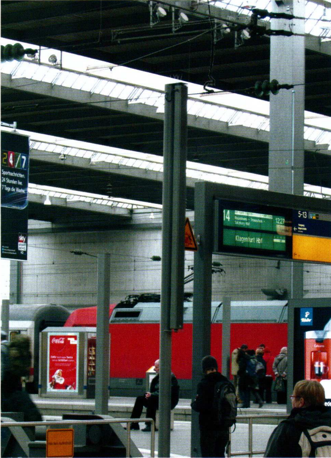
Eine von acht Intellivox-Säulen Typ DC280 am Querbahnsteig
