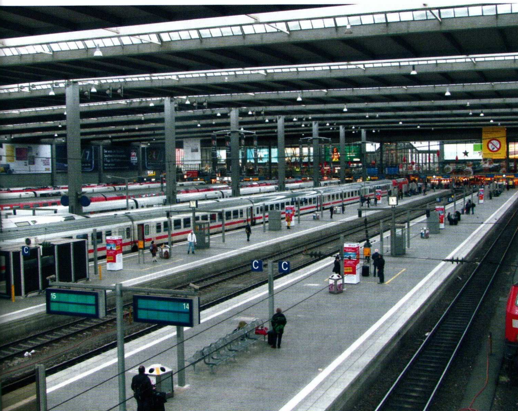
Zur Beschallung der akustisch schwierigen Längsbahnsteige wurde die nach EN54-24 zertifizierte passive Lautsprecherzeile V90 von Duran Audio eingesetzt
