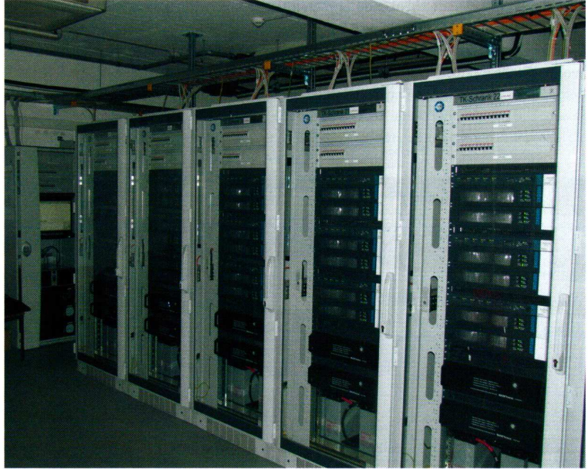
Technik-Schränke mit den VARIODYN-SAA-Komponenten
